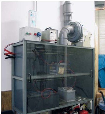
Platz sparende Alternative – Schrank zur Batterieladung mit Absaugung
