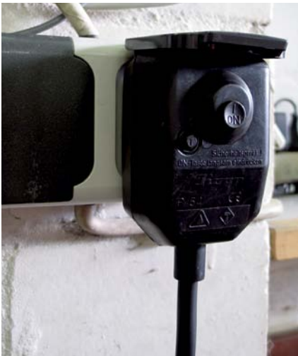
Verwendung eines Personenschutzschalters
