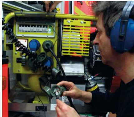
Überprüfung der Schutzmaßnahme eines tragbaren Stromerzeugers
