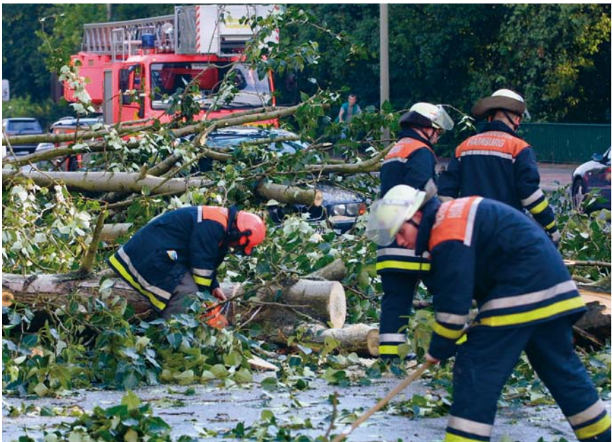
Motorsägearbeiten zur Beseitigung umgestürzter Bäume aus dem Verkehrsraum
