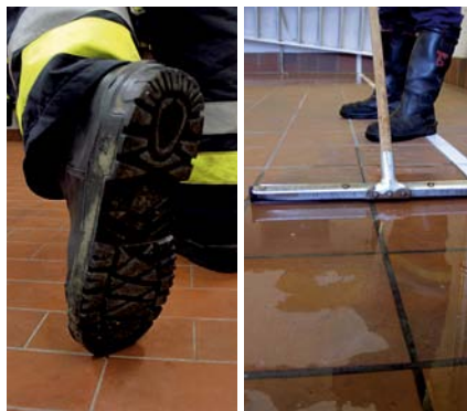
Trittsicherheit durch rutschhemmende Bodenbeläge
